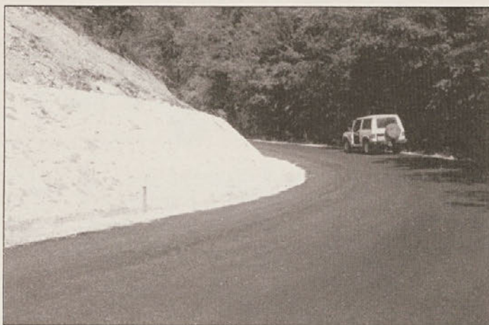
Urejena brežina na podkumski cesti.
