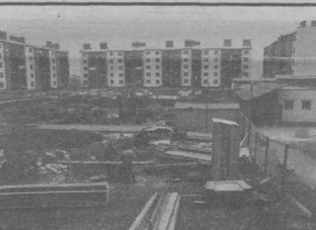
Gradnja prizidka k vrtcu v Novih Jaršah
