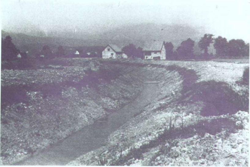
Sl. 1. — Fig. 1. Osuševalni jarek, izkopan v jezersko kreda. Vzhodno od Vrhnik. — The drainage ditch in lacustrine chalk east of Vrhnik
