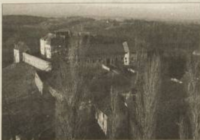
Pogled na negovski grad iz bližnjega cerkvenega zvonika. V ospredju je grajsko poslopje, ki je zagorelo zaradi močnega kurjenja s »kocanjem«.
