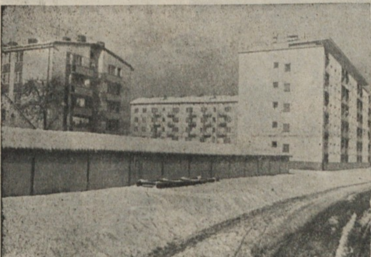
Stanovanjski blok B 4 in stanovanjski stolpič C 4 ob Kajuhovi c.
