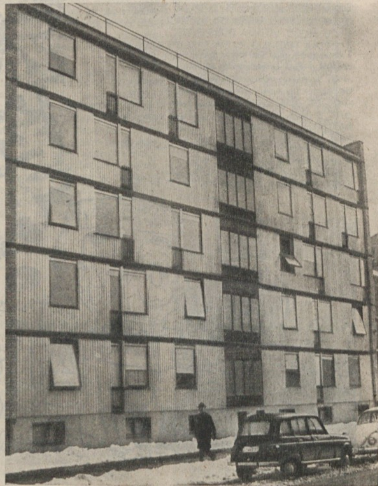
Samski dom milice v Kotnikovi ulici — Izvajalec SGP »Zidar« Kočevje
