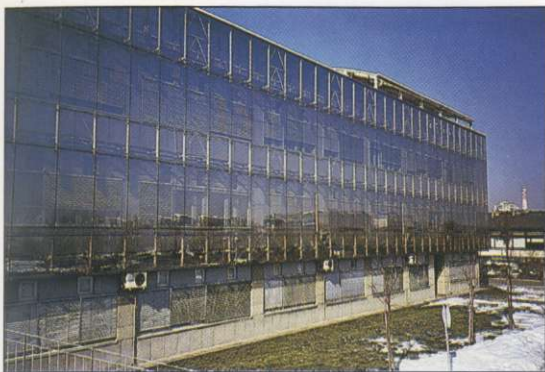
Slika 1: Poslovna stavba ob Litijski cesti v Ljubljani.
