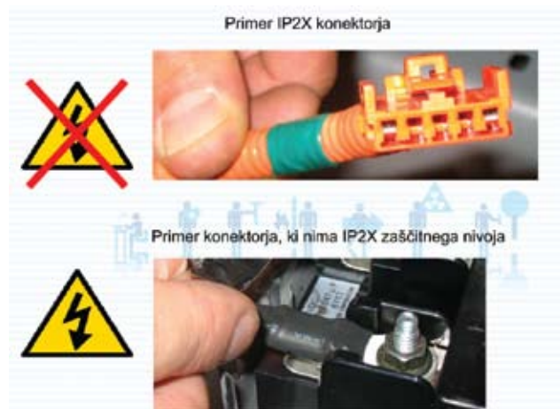
Slika 3: Primer ustrezne zaščite in neustrezne zaščite pred neposrednim dotikom
