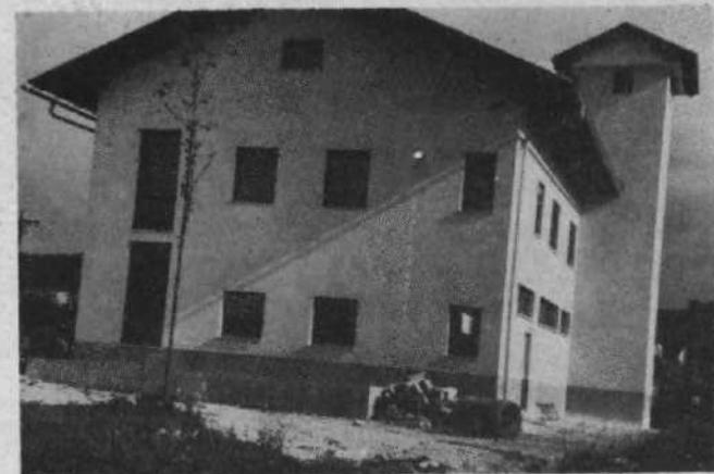
Novi gasilski dom v Dolu.
