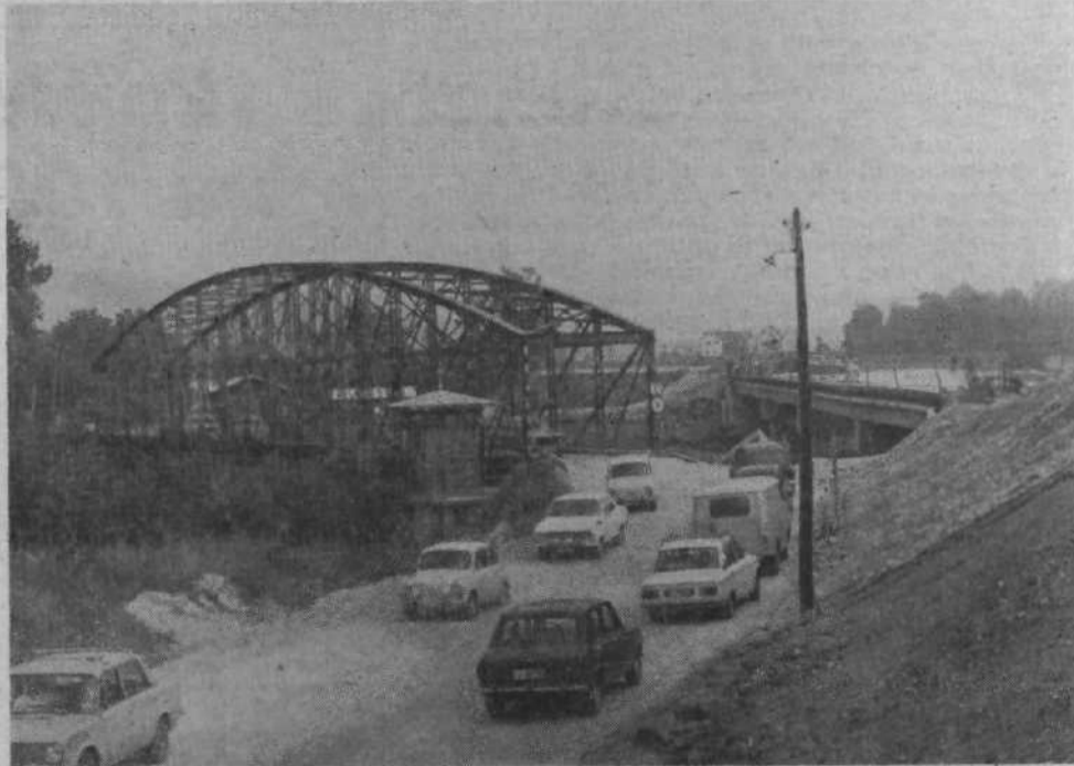
Promet po novem mostu čez Savo pri Šentjakobu bo tekkel po dveh vozniških pasovih. Vozišče bo široko 8 metrov s pločnikoma ob robu, širokima po meter in pol. Železni stavec mora vzdržati do otvoritve betonskega lepoteča.
