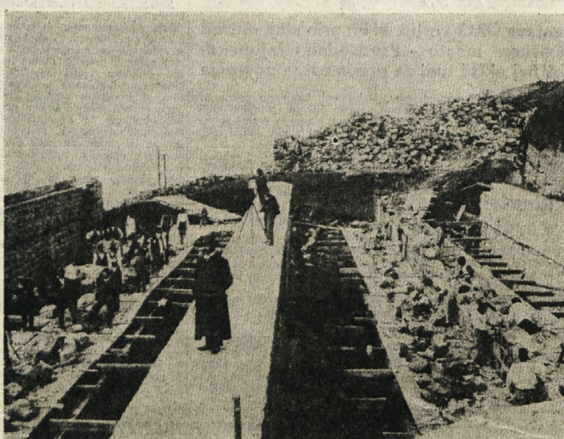
Med gradnjo nabrežinskega vodovoda v bližini kriške Brojnice v prvih letih stoletja.
