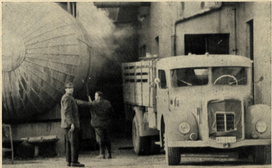
M. Slokan Pred našo kotlarno
