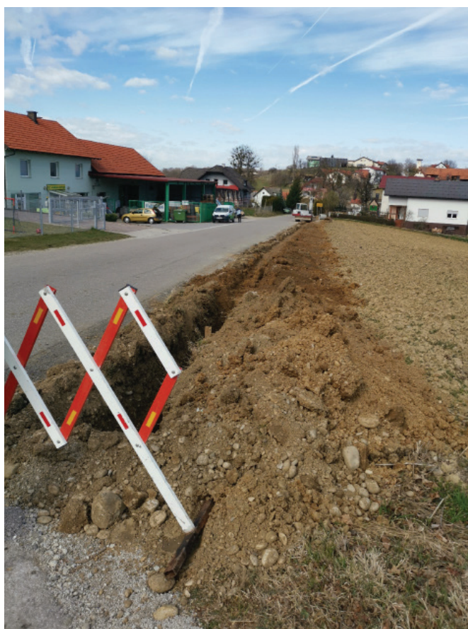
Uredili odvod vode od cerkve do križišča Šilec
