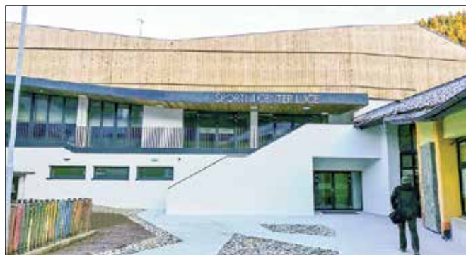
Investicija v Športni center Luče je bila delno pokrita iz lanskega in delno letošnjega proračuna. (Fotodokumentacija Občine Luče)
