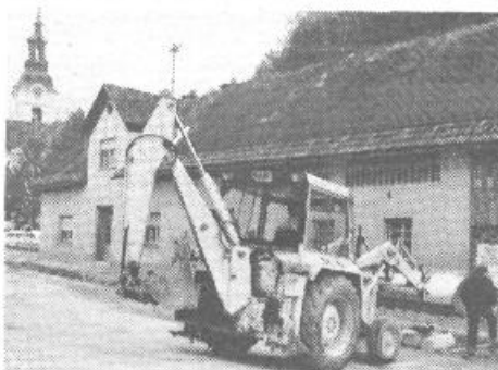
Nadaljevanje gradnje kanalizacije
