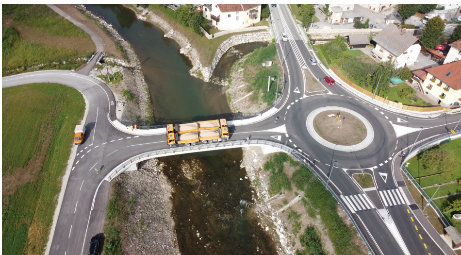
Težnostni preizkus novega mostu čez Soro, desno novozgrajeno krožišče na regionalni cesti.
