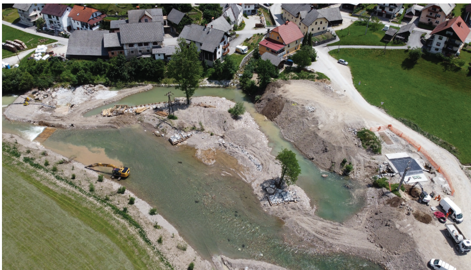
Prestavitev Sore pri Hotovljji. (foto: arhiv Gorenjske gradbene družbe)
