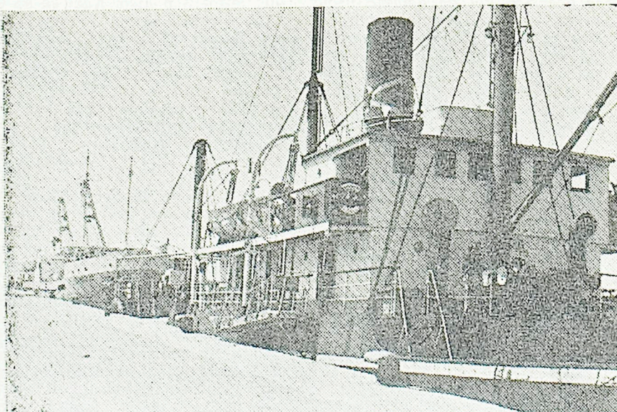
Nova operativna obala postaja že pretesna in prekратka za naraščajoči promet. Pokazalo se je, da dve ladiji srednje tonaže komaj še skupaj pristaneta ob 136 in pol metrih sedanje operativne obale, zato je nadaljevanje gradnje nadaljnjih vsaj 60 metrov kar najbolj nujna naloga in potreba. Na sliki: parnik »Hercegovina« z Reke in moderna motorna rečno pomorska ladja JRB iz Beograda »Tammava« skupaj v novem pristanišču minuli teden
