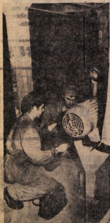
Elektrikar Maks Kočiš in učenec Božo popravljata električne naprave na rafinacijski peči
