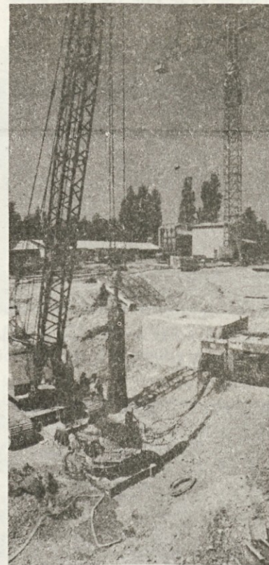
Pri izkopu temeljev smo morali postaviti dodatno utrditev s piloti. Izkop teh temeljev se nadaljuje v gradbeno jamo 25-tonske talilne peči.
