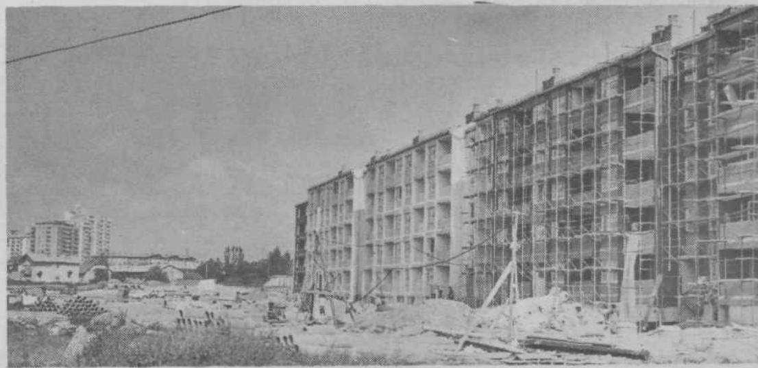
Na gradbišču v Štepanjskem naselju je ves dan zelo živahno. Tudi gradbenec je deževni oktober pošteno zagodel, zato velja zamujeno nadoknaditi, kajti prva stanovanja bodo predvidoma vseljena že v novembru
