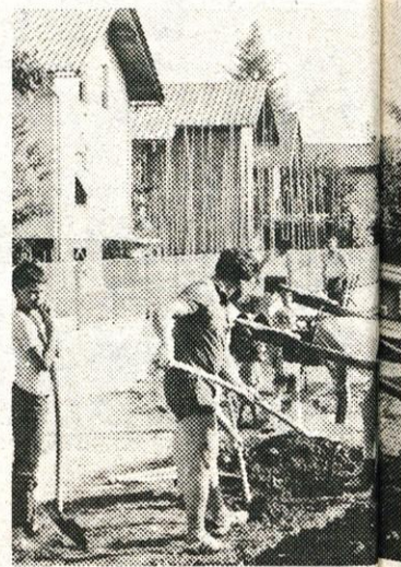
Zaključna dela na igrišču.
