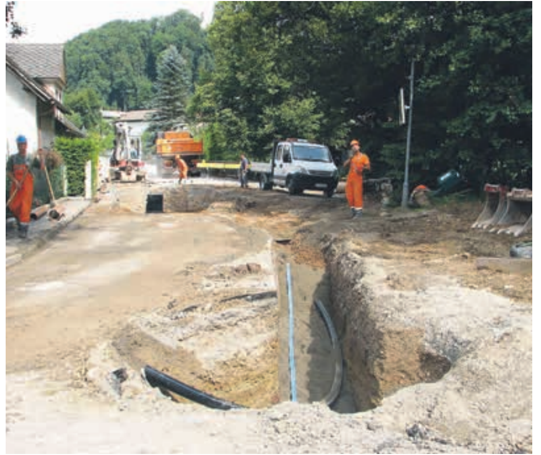
Vakuumsko kanalizacijo bodo letos začeli graditi v okolici šole, na Dragomerški in Stari cesti.
