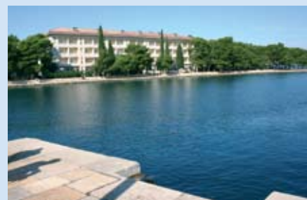
Opustele stavbe, za obnovo najbrž ni denarja
