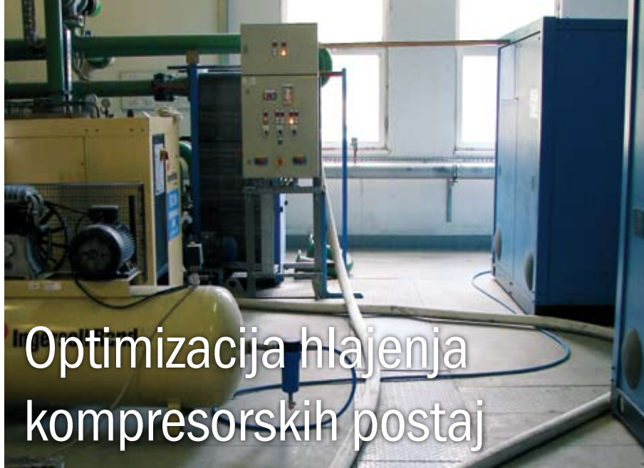
Industrijski testi hlajenja 7,5 barske kompresorske postaje
