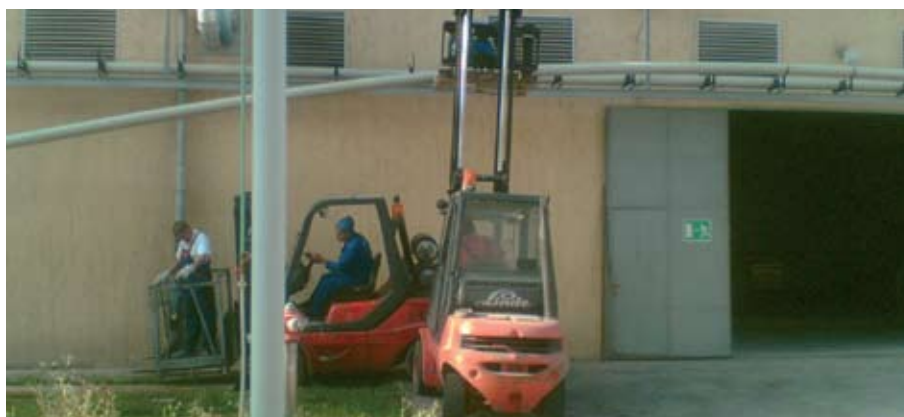
Izvedba cevovodov za hlajenje kompresorskih postaj
