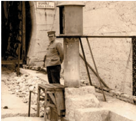
Z limnigrafom so v 60. letih merili višino iztekajoče vode, na podlagi dobljenih podatkov pa izračunali njen pretok (arhiv nekdanje SVP Nova Gorica).
