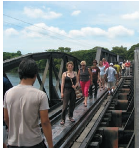
Ukrivljeni nosilci črnega železa na mostu na reki Kwai.
