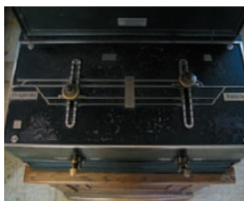
Signalna varnostna naprava oziroma prometniški blok na postaji Središče, ki je bil v uporabi do 24. februarja 2010.
