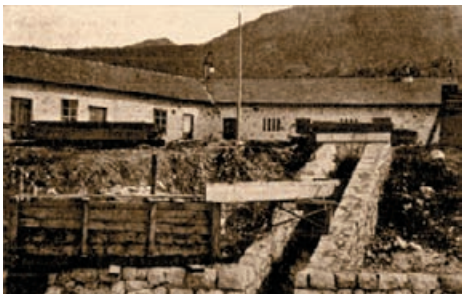
Med gradnjo predora so pretok predorske vode merili z uporabo lesenega korita. Zaradi naraščajočih količin in natančnejših meritev pa so pozneje uporabili t. i. Voltmanovo krilo (iz knjige Der Bau des Wocheiner Tunnels).
