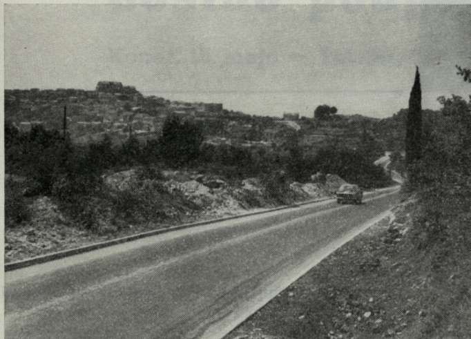
Rekonstrukcija 30 km cest po Istri. Modernizirani odsek Vrsar — Lim
