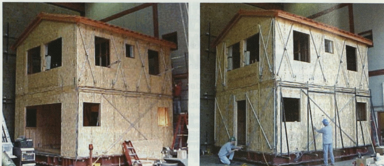
Slika 1: Analizirana dvonadstropna lesena okvirna konstrukcija na potresni mizi. Pogled s severno – vzhodne strani (levo) in z jugo – zahodne strani (desno).
