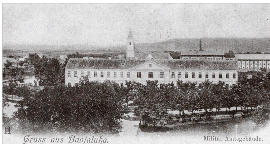
Stavba vojašnice v Banjaluki, ki so jo avstro-ogrske oblasti zgradile kmalu po zasedbi Bosne in Hercegovine leta 1878. Danes je v stavbi Arhiv Republike Srpske (Verica M. Stošić in Nebojša Radmanović, Banjaluka. Centar Vrbaske banovine (Banja Luka, 2019), str. 86)
