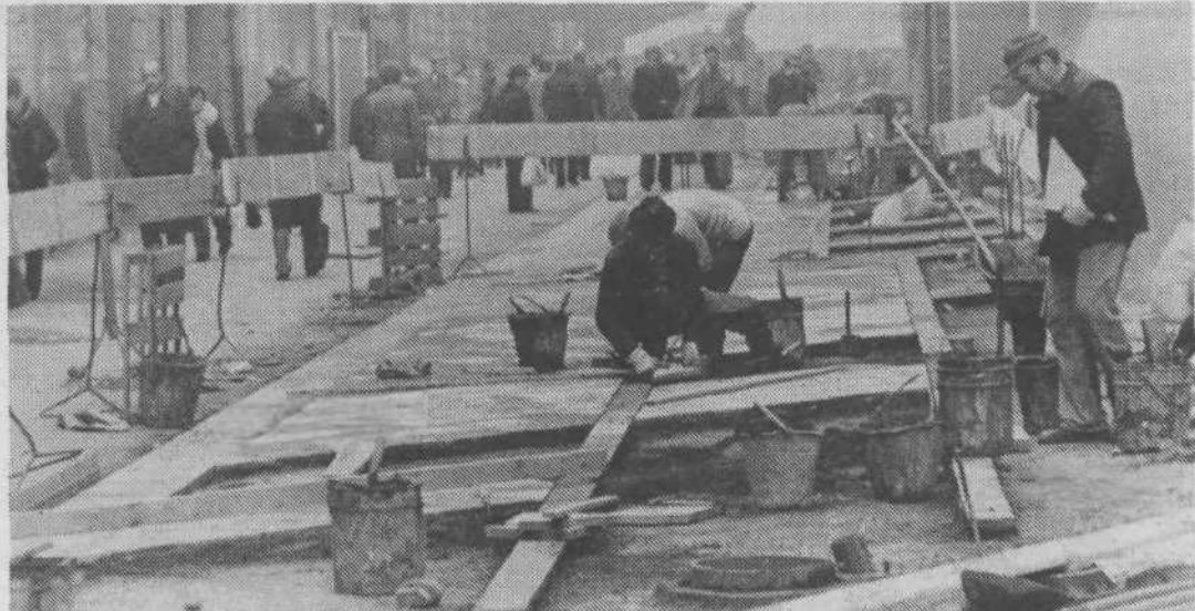
Tako je bilo na Čopovi lani, ko so delavci polagali tlak. Delo so organizirali tako, da je bil skoraj ves čas med obnovo Čopove prehodni vsaj del cestišča.
