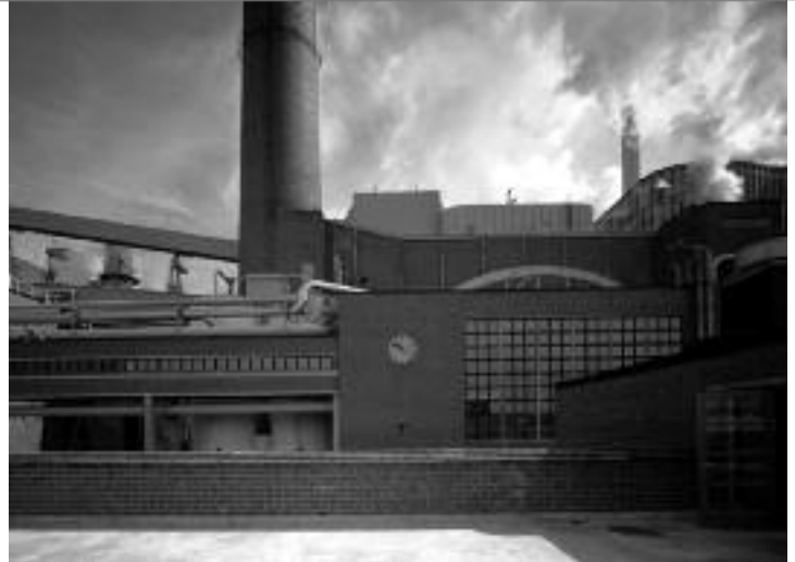
2. Mlin za celulozo, Sunila, 1936. Območje mlina za celulozo Sunila (Kotka) je hvalnica opečni industrijski arhitekturi.
