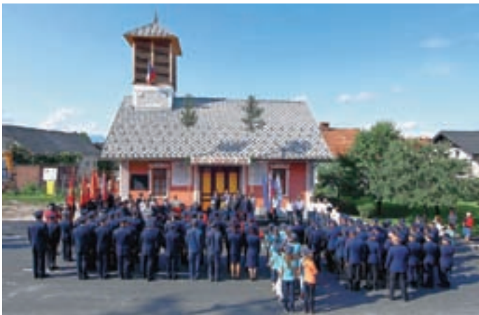
Sorški stari gasilski dom je pred desetletji zamenjal večji in sodobnejši. Po obnovi je jubilat spet tak kot pred stoletjem.
