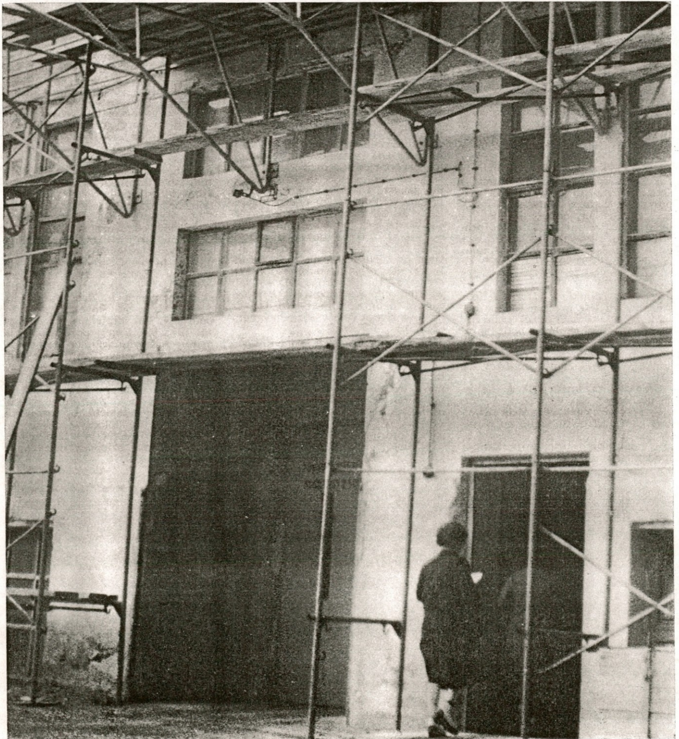
Pred zimo si bo novo »obleko« nadela stavba predilnice.
