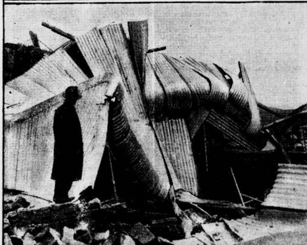
Novi Zeland, sosed Avstralije, je postal vnovič žrtev potresa. Na zgornji sliki vidi-mo most v Wairoi, ki so ga zgradili po lanskem potresu in je bil zdaj zopet uničen. Spodnja slika kaže razdejanje jeklene lope, ki so jo potresni sunki zvilii kakor košaro iz lubja
