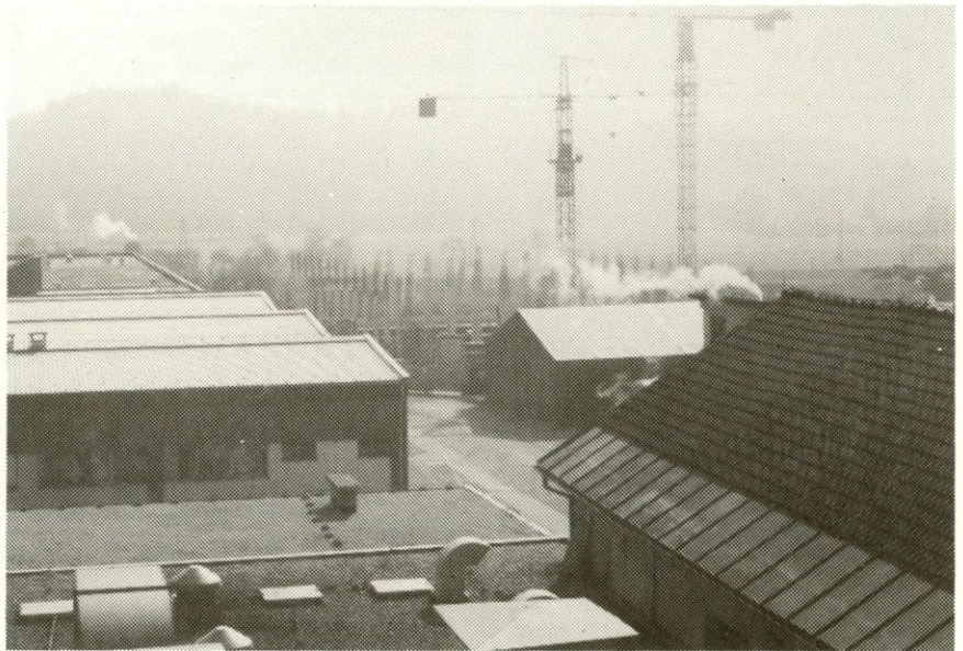
Pogled na gradbišče v sredini oktobra
