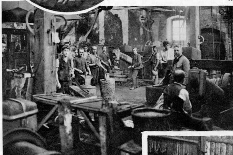
Rezanje jeklenih palic za kose in srpe ter prirezovanje in glajenje kos.
