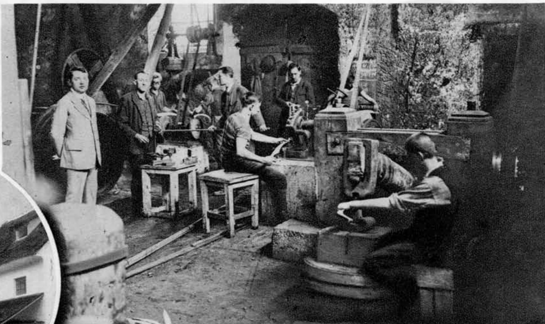
Rezanje jeklenih palic za kose in srpe ter prirezovanje in glajenje kos.
