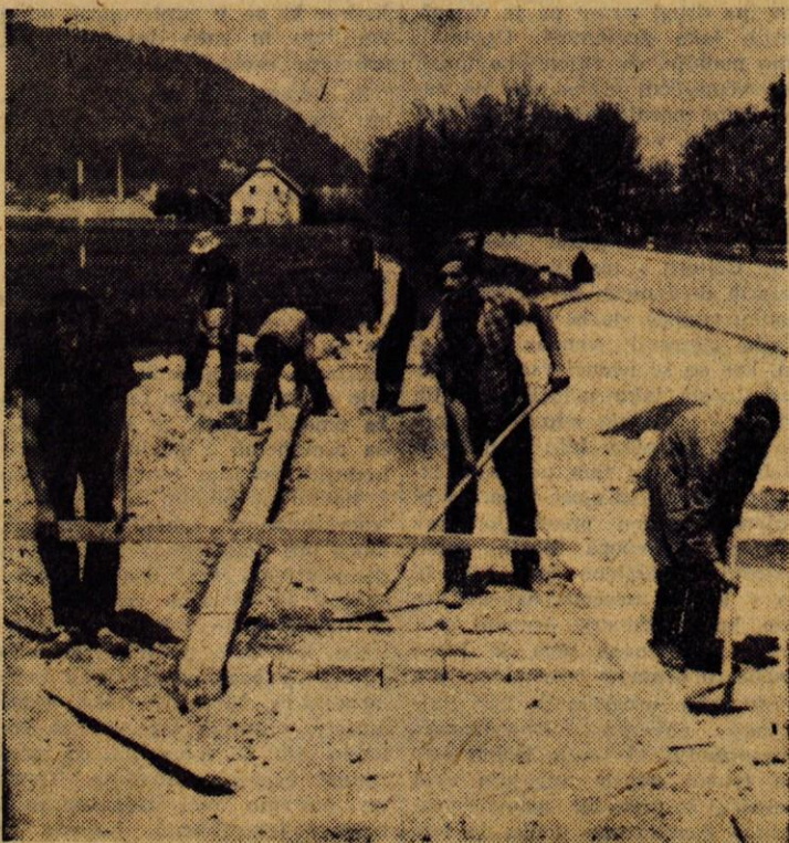
Ob cesti I. reda Kranj—Ljubljana v naselju Orehek so v preteklem tednu asfaltirali avtobusno postajališče. Nedvomno bi bilo treba to storiti tudi z drugimi izogibalšči vzdolž te ceste
