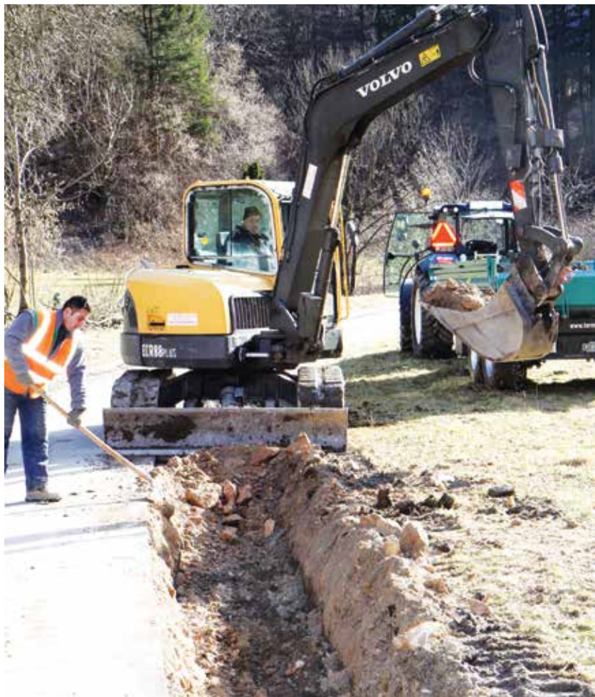
Pričetek gradnje vodovoda v Zaplanini
