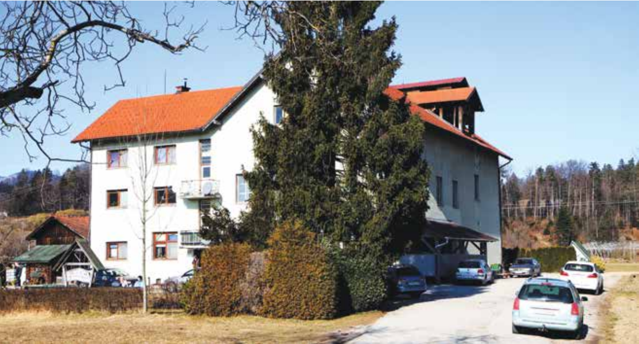
V nekdanji sušilnici hmelja v Letušu bodo zgradili deset stanovanj.
