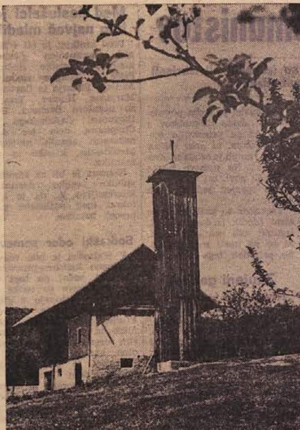
Pred dvema letoma so gasilci s Tanče gore začeli s pomočjo vaščanov okoliških vasi dozidavati star gasilski dom. Opravili so že veliko prostovoljnih delovnih ur in prispevali precej materiala, ker za gradnjo ne dobijo nobene finančne pomoči. Od jeseni je prenovljeni gasilski dom že pod streho, računajo pa, da bo dograjen šele 1969. (Foto: R. Bačer)
