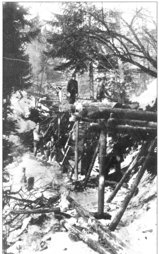
Gradnja riže v Grohotu leta 1935. Na ogrodju stoji znani "rižmojster" iz Luč. Sliko hrani Muzejska zbirka Mozirje.
