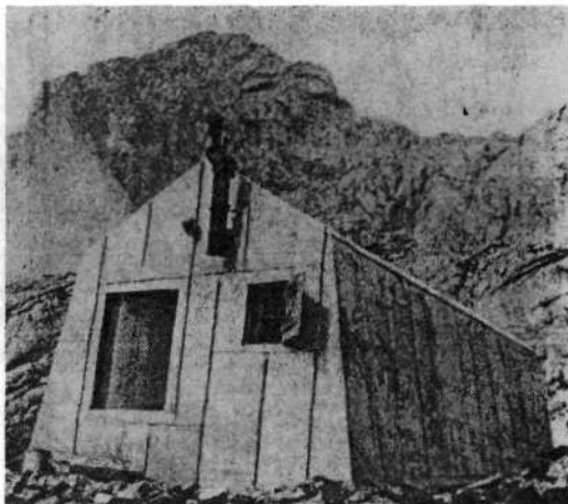
Bivak na Malih podih pod Skuto (2070 m — arhitekt Vlasto Kopač)
