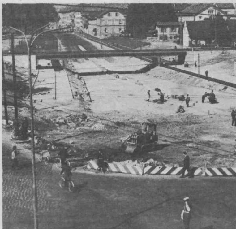
Podvoz na Celovški cesti med gradnjo. Foto: R. Pleterski
