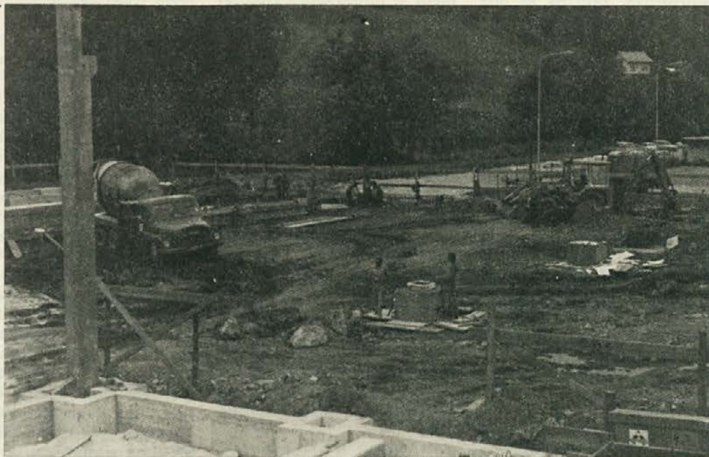
Začetek gradnje nove proizvodne hale — prvi steber
