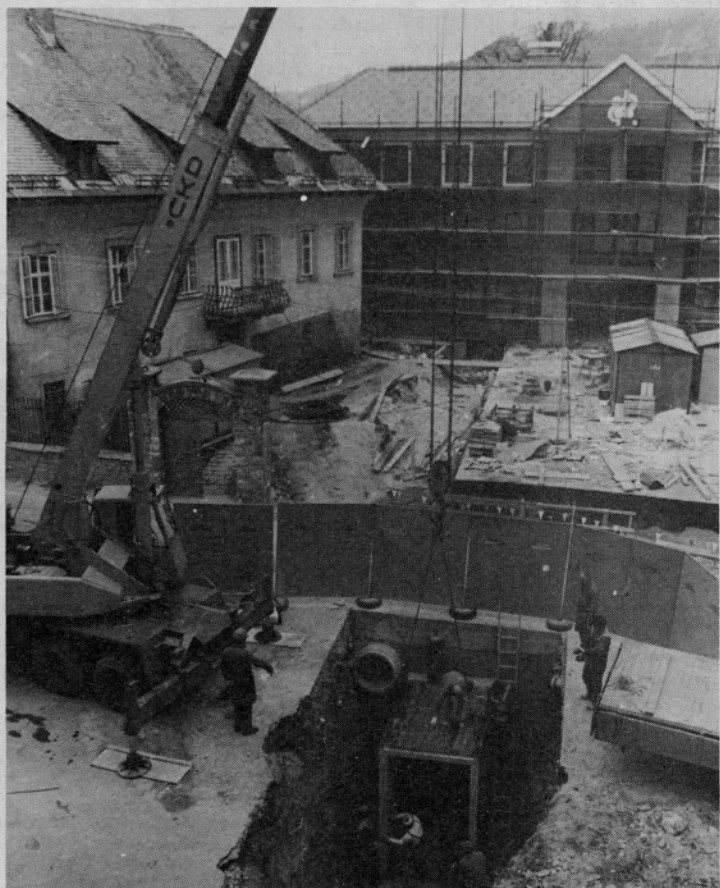
Gradnja centra ter podhoda do upravne stavbe
