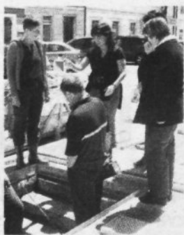
OBNOVA BREŽIŠKE ULICE:
