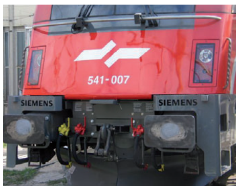
Po popravilu v odličnem stanju ponovno na železniških tirih
