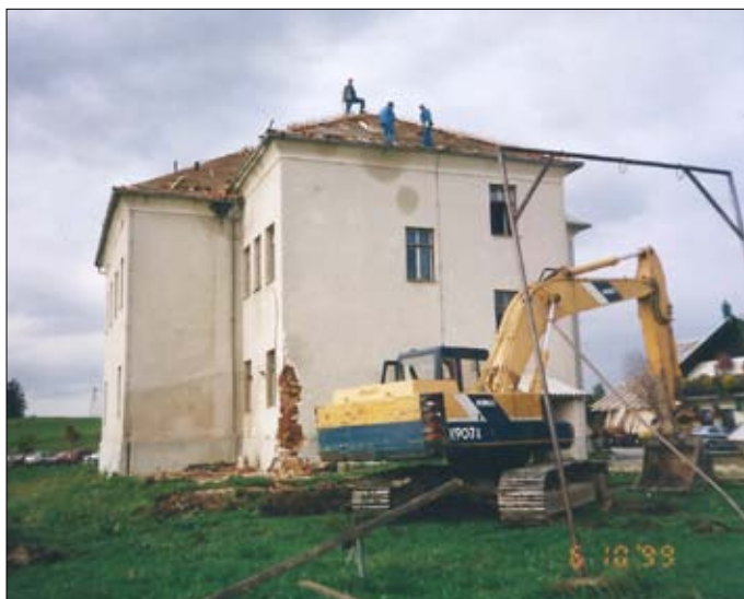
Rušenje stare šole, 1999
