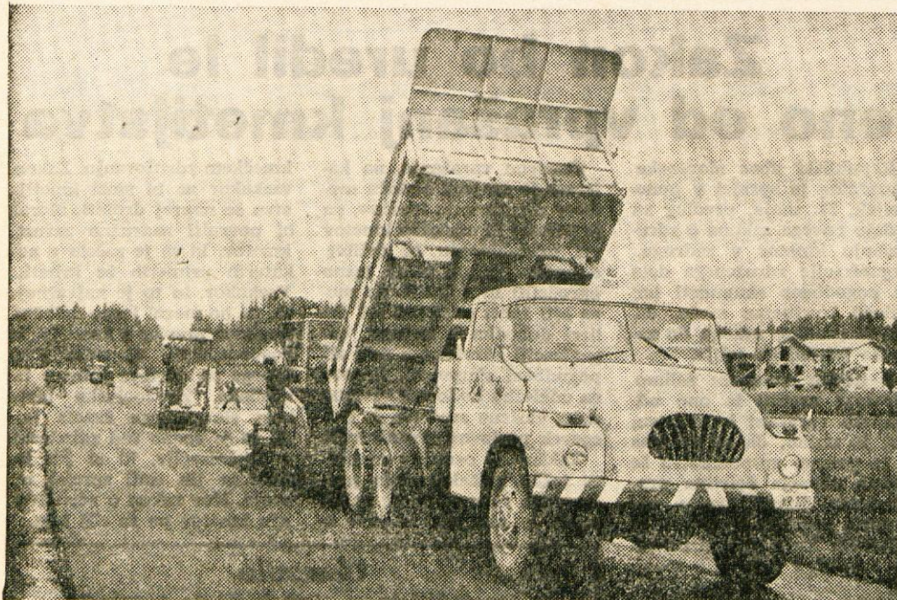
Delavci Cestnega podjetja iz Kranja že dober teden asfaltirajo cesto od Kranja proti Brniku. — Foto: F. Perdan
