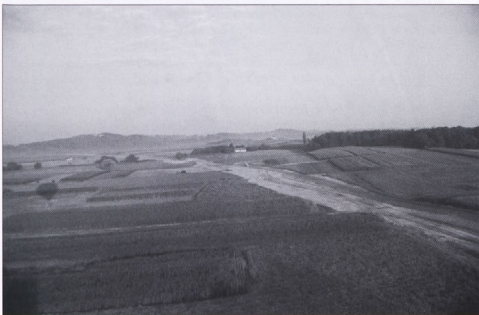
Slika 1: Obvoznica Ormož 1997: Pogled na traso ormoške obvoznice med Hardekom in Hajndlom z jugovzhoda iz balona. Foto: Ivan Tušek
