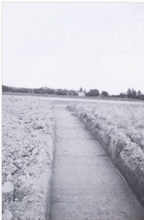
Slika 14: Obvoznica Ormož, Hardek 1997: Strojna sonda 12 ob cesti proti Središču ob Dravi. Foto: Ivan Tušek
