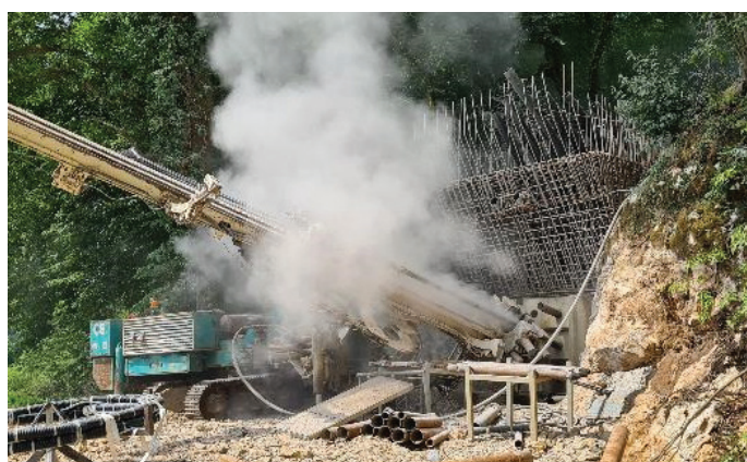
Slika 14. Vrтанje sider opornika 2.
