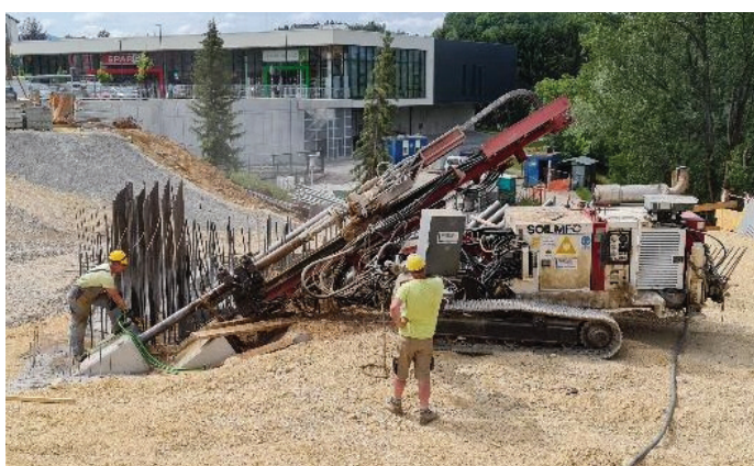
Slika 13. Vrтанje sider opornika 1.
