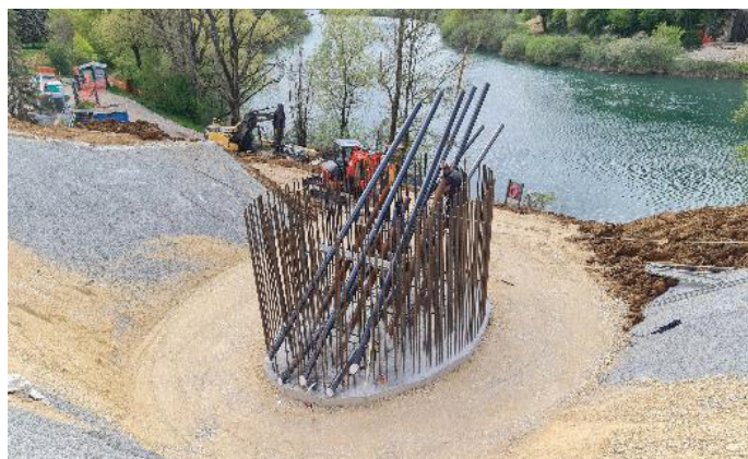
Slika 12. Opažne cevi v zgornjem sloju vodnjaka 1.
