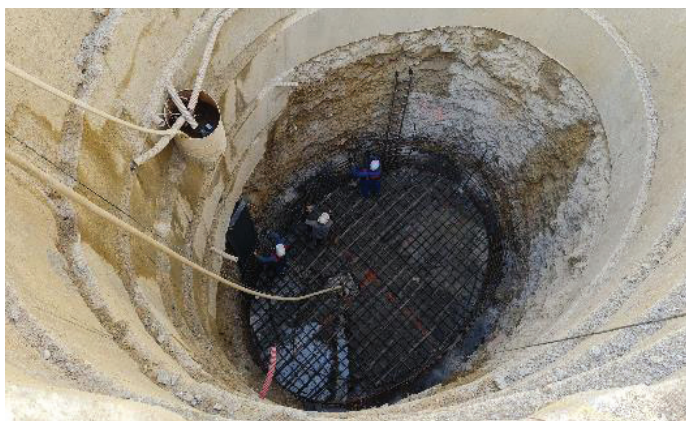
Slika 11. Armatura dna vodnjaka 1.
