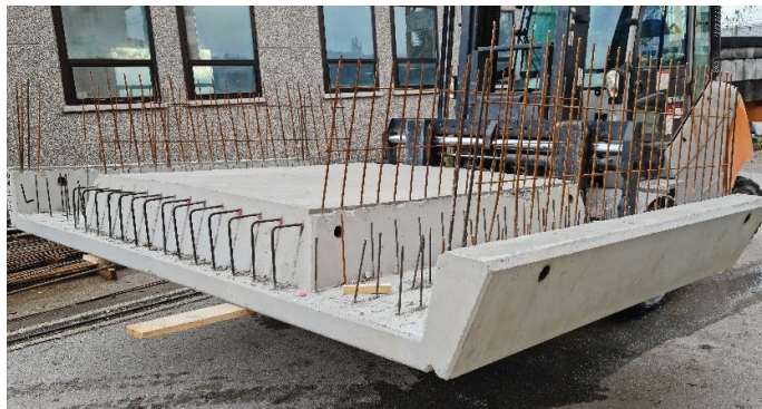
Slika 18. Predizdelani betonski element.
