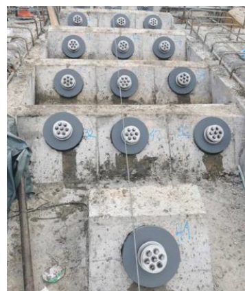
Slika 16. Pogled na že napeta sidra drugega nivoja opornika 1.
