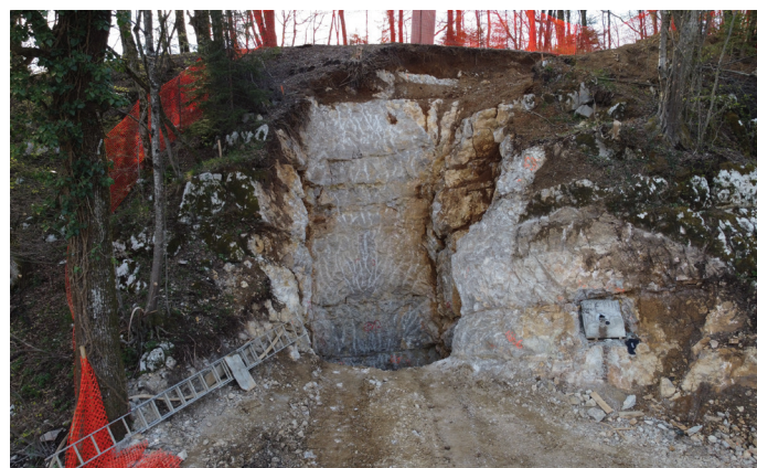
Slika 10. Pogled na izkop vodnjaka 2.
