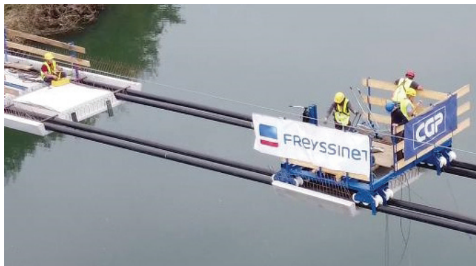
Slika 20. Montaža elementov s specialnim vozičkom.
