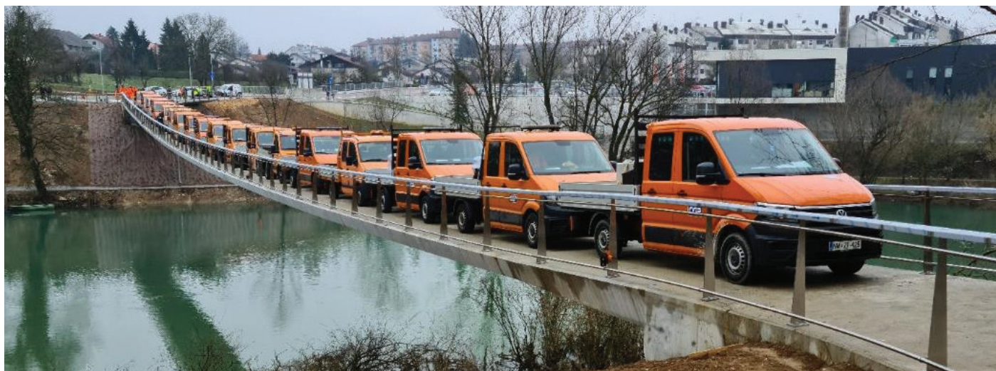
Slika 25. Maksimalna obremenitev z 18 vozili med obremenilno preizkušnjo.
