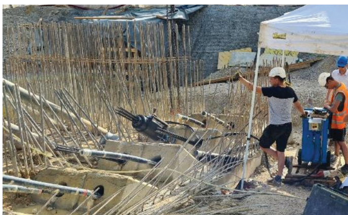
Slika 15. Napenjanje sider spodnjega nivoja opornika 1.
