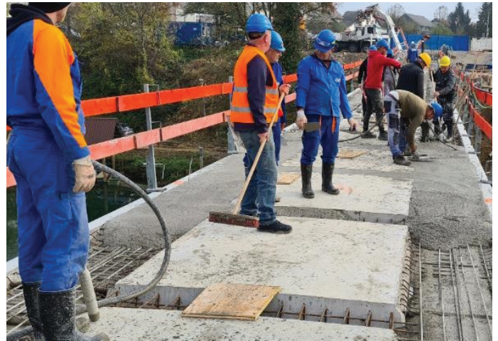
Slika 21. Betoniranje utorov prefabriciranih elementov.
