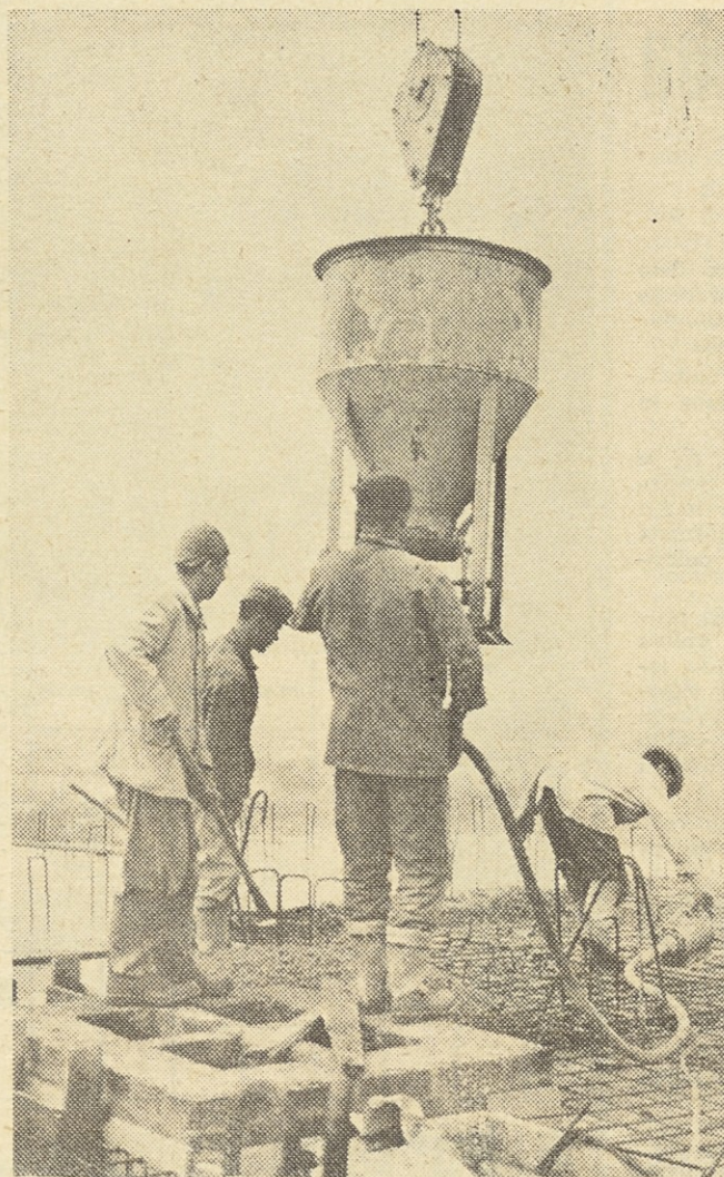
Betoniranje na stolpnici.
