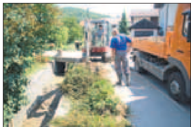
Dela pri menjavi vodovodnih cevi na Stari cesti
