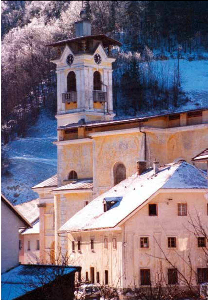
Zvonik cerkve sv. Antona pred prenovo leta 1996. Foto: Anton Sedej
