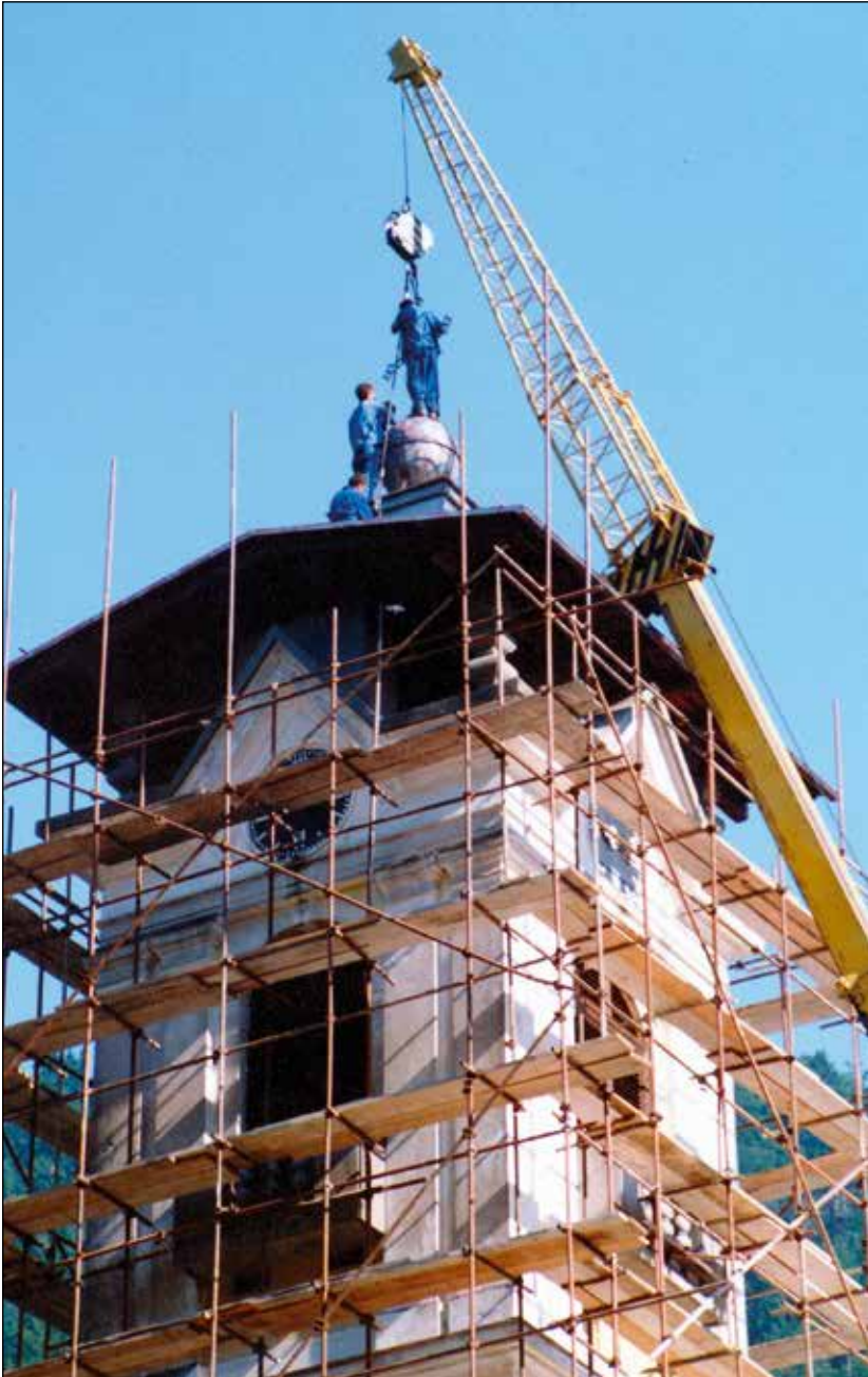
Podiranje strehe obstoječega zvonika leta 1997. Foto: Anton Sedej
