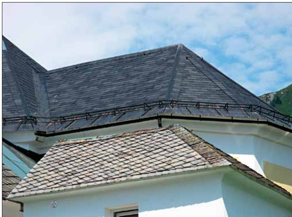
Napačno izbran tip ploščic v Sorici. Ohranjen objekt ob cerkvi jasno nakazuje, kakšen bi moral biti. Foto: Arhiv družine Ferlan
