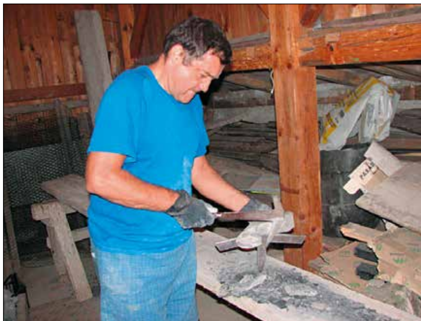
Klesanje skrilnih ploščic. Foto: Arhiv družine Ferlan
