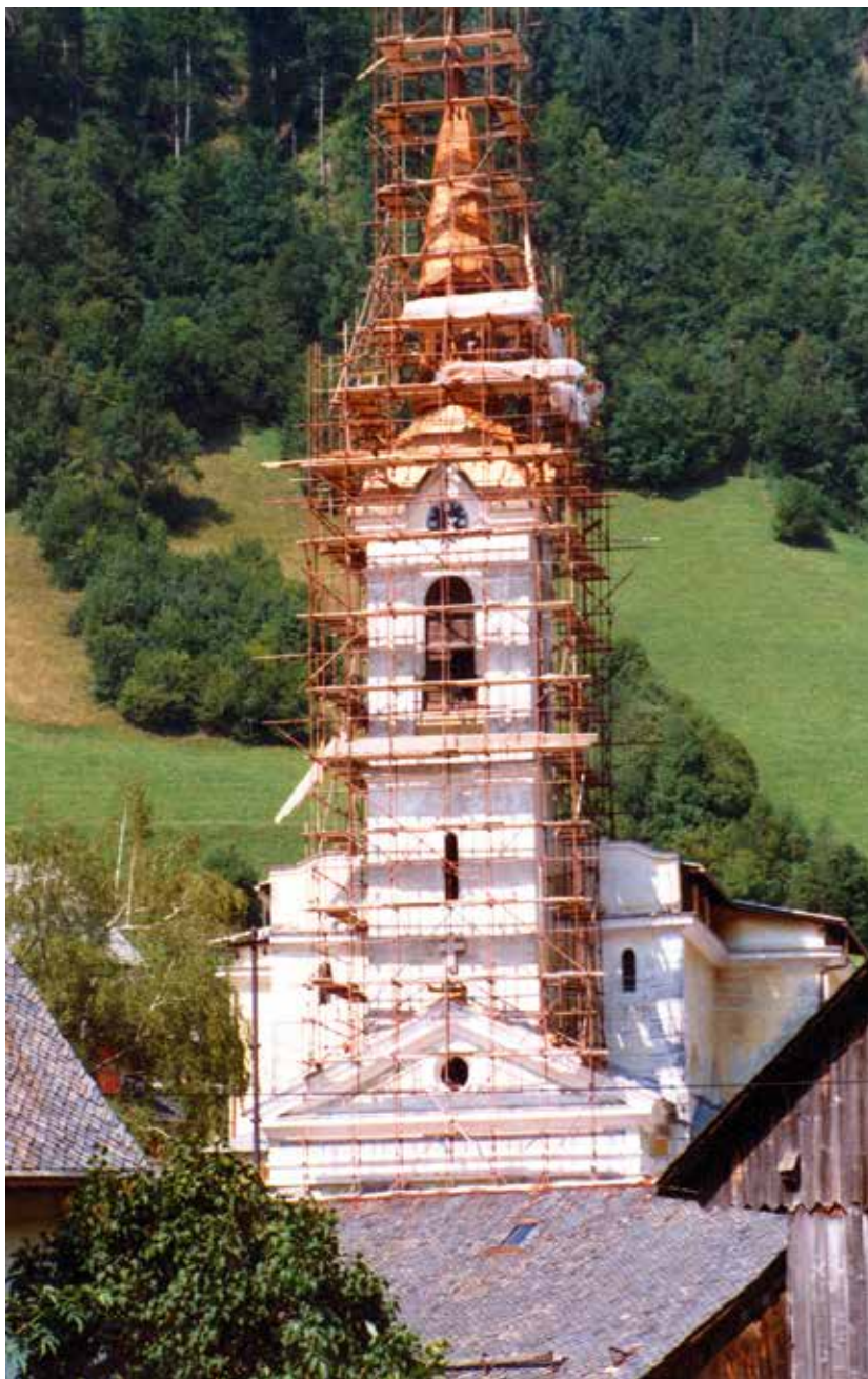
Streha zvonika je pripravljena za polaganje ploščic. Foto: Anton Sedej
