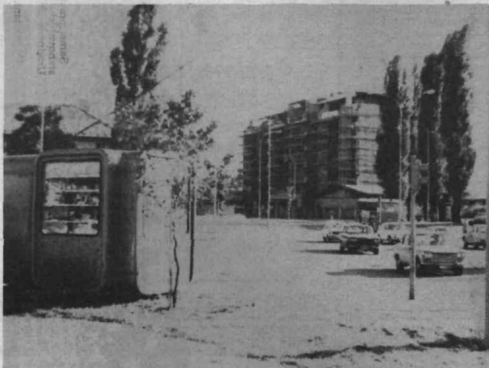
Novi poslovni center Commerce ob Einspielerjevi ulici bo zajemal kar 7.500 neto kvadratnih metrov površin. Predračunska vrednost vseh del na tem objektu, brez stroškov za pripravo zemljišča, znaša skoraj 10 milijard starih dinarjev.
