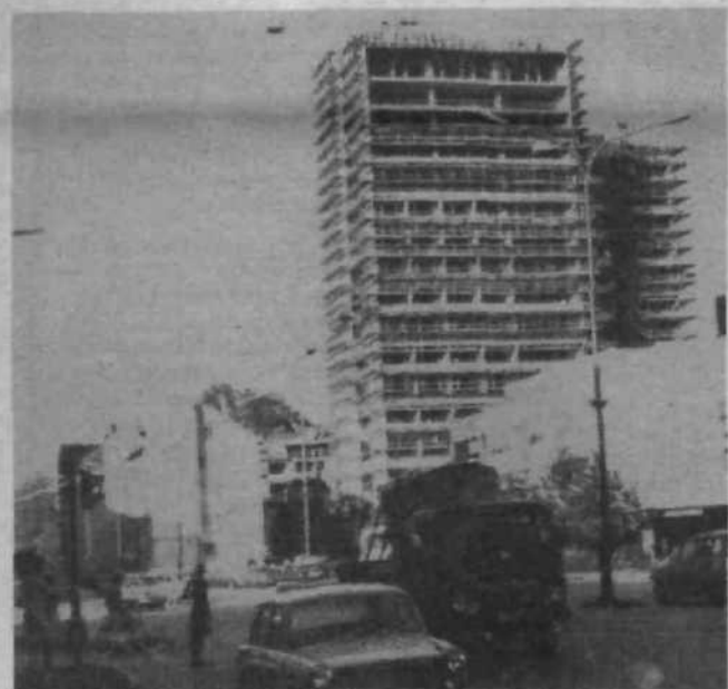
Velikan iz betona, zgrajen nad novo bežigradsko tržnico, prekaša vse do sedaj zgrajene stolpnice Bežigradom. Uporabnikom poslovnih prostorov v le-tem želimo predvsem brezhibno delovanje dvigal.
